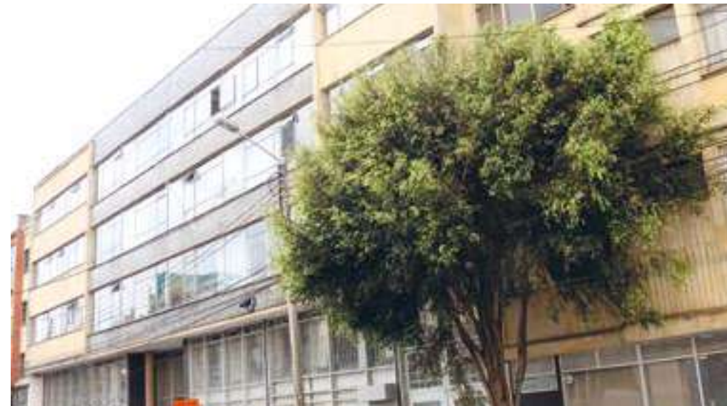
Sede Edificio Administrativo, adquirido por la Institución en 2011 Carrera 9A No.62-27 Inauguración: Semestre I-2012
